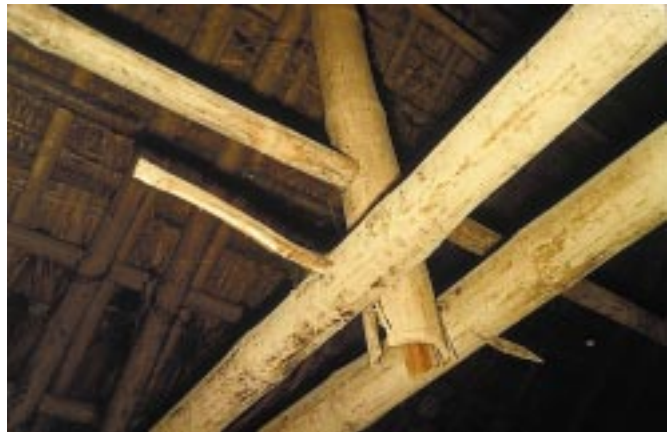
Fot. 7 - Konstrukcja bambusowego domu w Wietnamie
