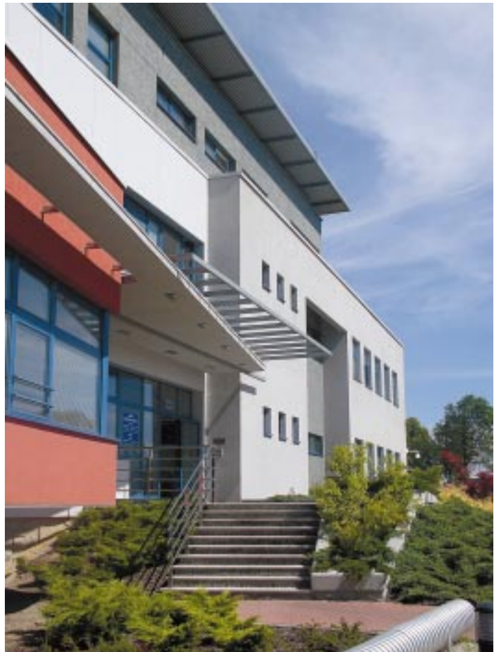
Zespół obiektów biurowo-technicznych Rejonu Energetycznego w Kłobucku – Wyróżnienie
