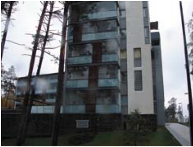
Budynki mieszkalne – Docksideresidence Aurinkolahti
