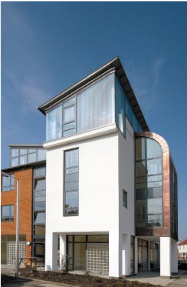
Nagrodzona realizacja Cała Domus w New Hall.
