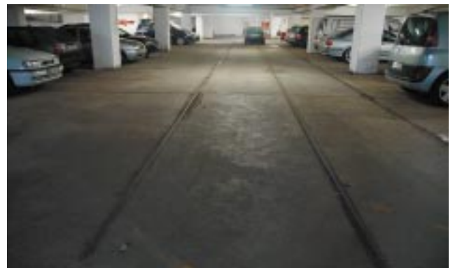
Fot. 1. Stan obecny – centralna część parkingu
