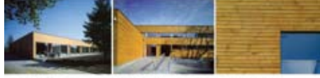
OSRODEK REHABILITACJI SPECJALNEJ I ZAWODOWEJ W OPOLU | CENTER FOR SOCIAL AND PROFESSIONAL REHABILITATION IN OPOLE | 2004 Architektura: Piotr Gierczyk, Arkusj Szewczyk
