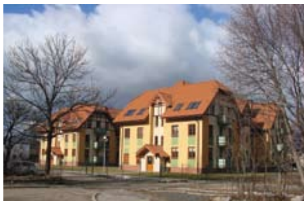
Laureat w kategorii MISTERA: zespół budynków mieszkalnych przy ul. Żłotniczej w Jeleniej Górze
