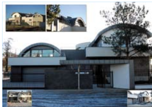
dom jednorodzinny Państwa Gordonów ul. Kartuska 24 (arch. arch Elżbieta Sudof-Czubaj i Jan Czubaj)
