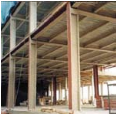
▲ Zabezpieczenia ogniochronne konstrukcji budowlanych: System natryskowy MCR ISOVERM HCT
