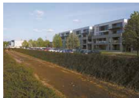
↑ Oś Królewska w Wilanowie – odtworzenie historycznego kanału, w którym nie ma wody (fot. P. Wolski)
