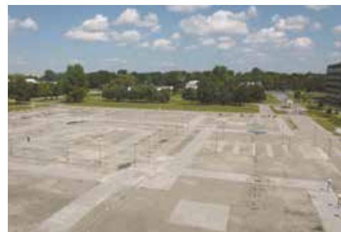
↑ Dwa zdjęcia ukazujące tę samą górną płytę parkingu podziemnego na terenie Szkoły Głównej Gospodarstwa Wiejskiego w Warszawie. Pierwsze przedstawia to miejsce po przebudowaniu w 2016 r., na podstawie projektu P. Wolskiego z Zespołem, a drugie jego stan w 2014 r. (po przebudowie marta powierzchnia płyty parkingu została pokryta trawnikiem z zielenią)
