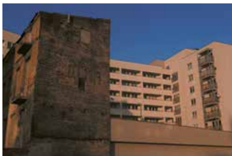
↑ Warszawa – Grochów, budynki przy ul. Chodakowskiej, których lata budowy różnią się około 100 lat (fot. D. Śmiechowski)
