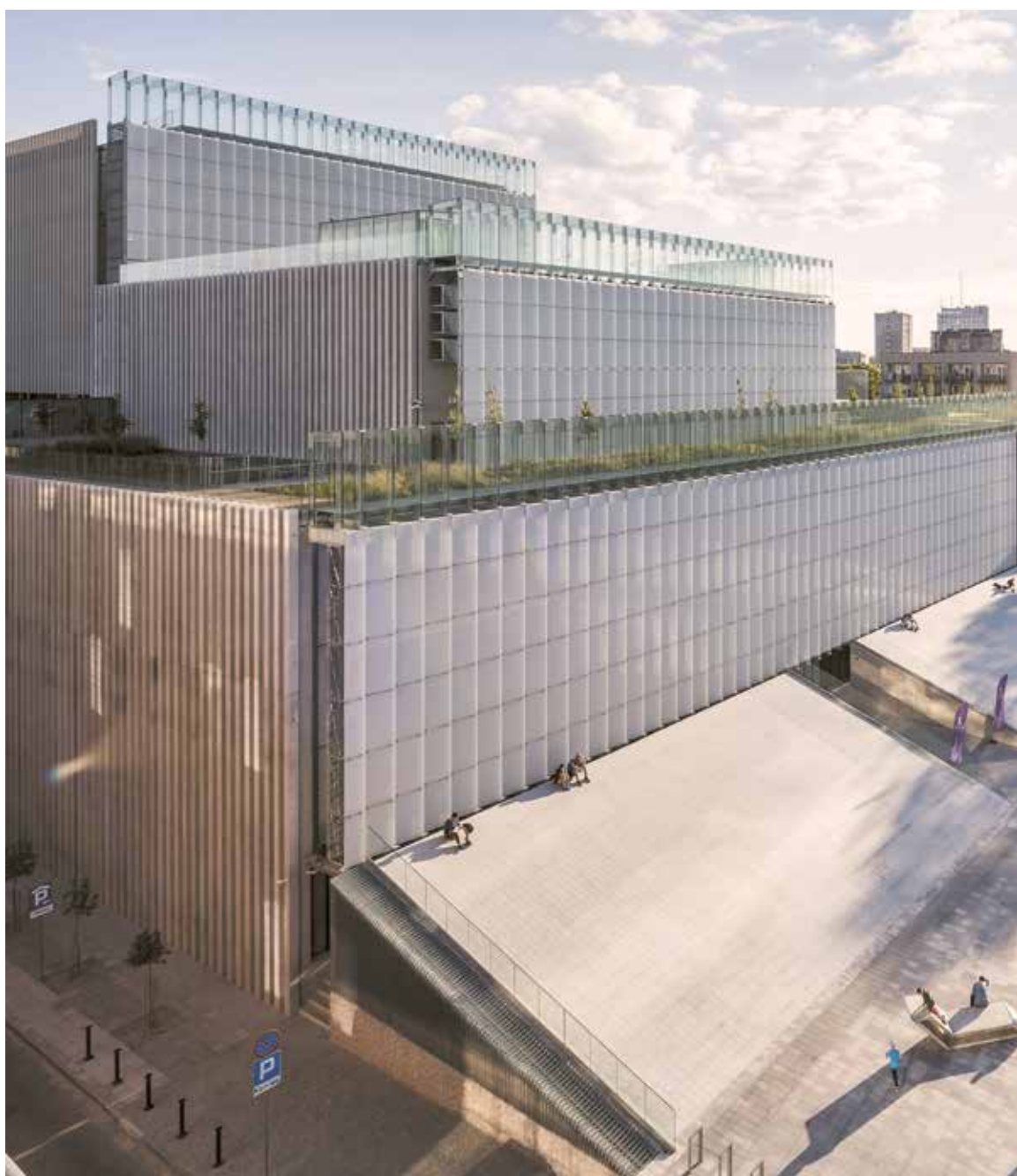
↑ Gmach Teatru w Budowie, Lublin – realizacja pokonkursowa – autor obiektu Bolesław Stelmach i partnerzy (fot. B. Stelmach)
