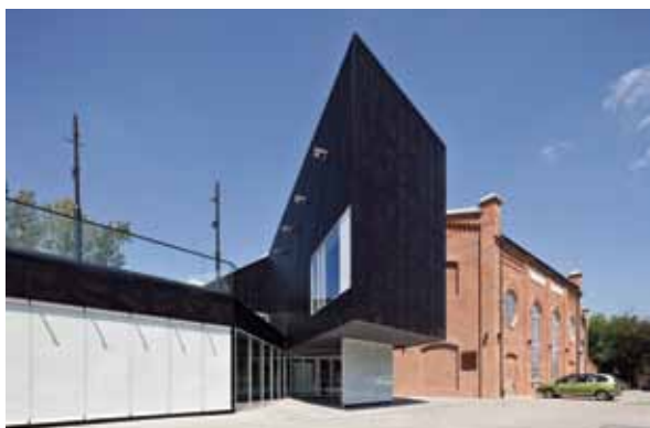
→ Mazowieckie Centrum Sztuki Współczesnej Elekrownia w Radomiu – adaptacja budynku elektrowni z początków XX wieku
