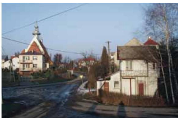
→ Nieład i pomieszanie. W rejonie Sędziszowa, województwo podkarpackie
